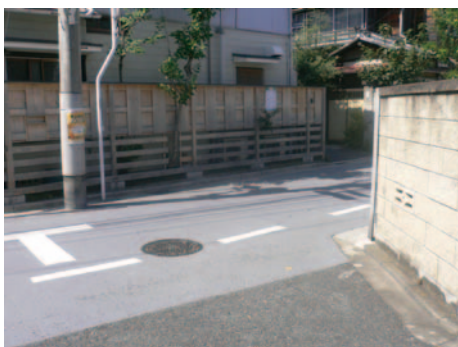
路面温度の上昇を抑制する舗装 (手前は通常の舗装)
